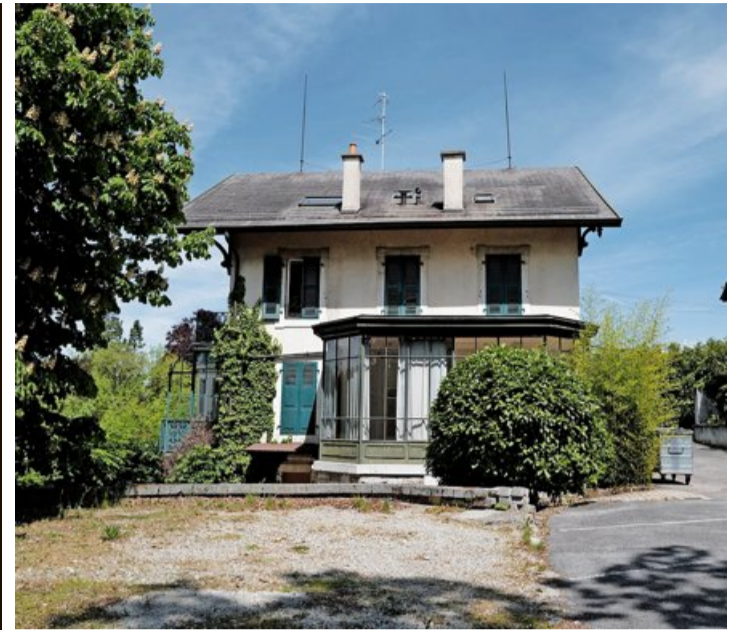
La maison Decroux, construite en 1870, borde de près la route de Thonon. Elle devrait être détruite. STEVE YUNCKER
